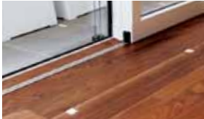
Laufschiene dezent im Fußboden eingelegt.
